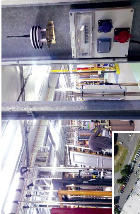
Des capteurs mesurent la température et l'humidité dans l'usine.
