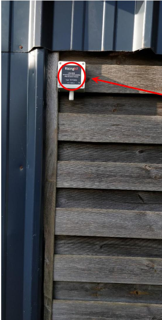
**Capteur de température extérieure fixé l'abri à proximité du local TGBT.**
